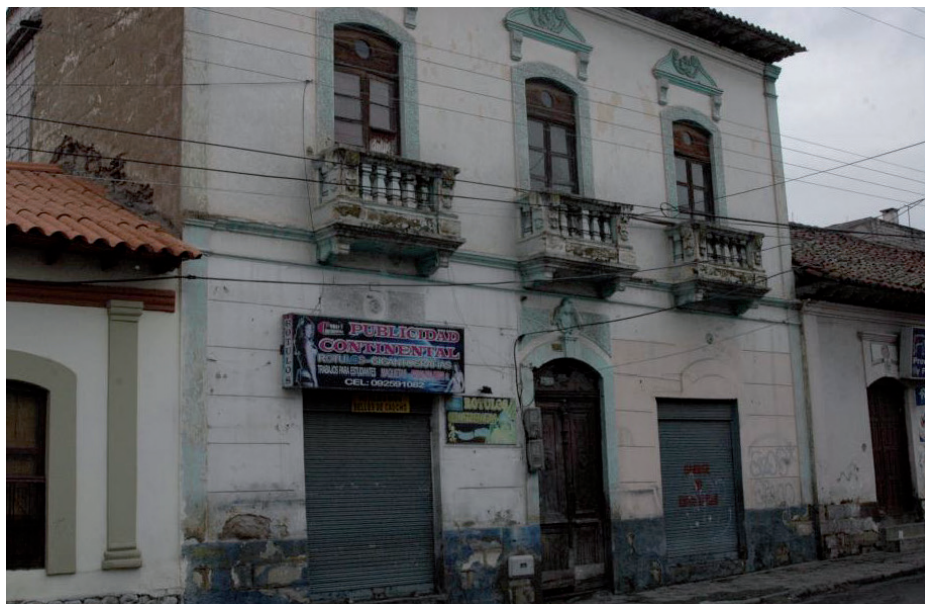
Fig. 18.- La cornisa tan débil, el alero, el detalle de las pilastras esquineras, el almohadillado solo con bisel horizontal conseguido con enlucido, el débil marcapiso y la pared de adobe lateral, entre otros detalles, modifican las normas neoclásicas. (Riobamba).
